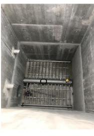
L'eau arrivant des bassins de décantation est introduite par le bas des réacteurs (1) et via les diffuseurs (2). L'alimentation se fait par le bas (3) pour empêcher au maximum le bouchage des diffuseurs.
